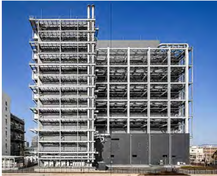
データセンター外観
