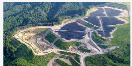
君津箕輪第二太陽光発電所
