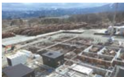
建設中の米沢南発電所
