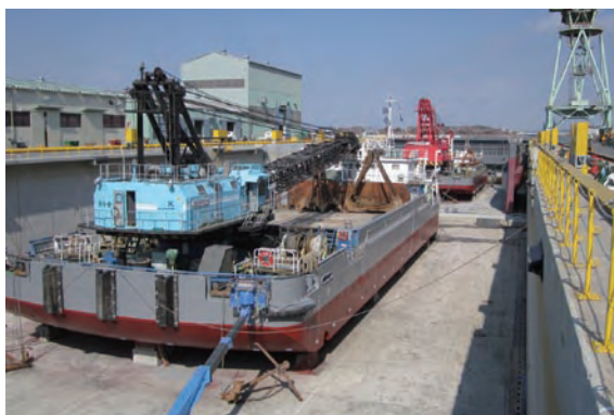
使用が開始された修復ドック
