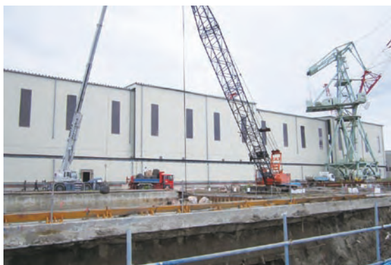
被災工場(造船業)の修復工事の様子
