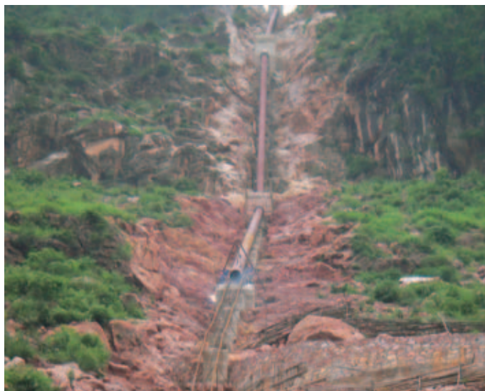
『ワールドクールボンド』に排出権を提供する中国紅岩小規模水力発電プロジェクト。急勾配を利用して発電用の水管を通す
