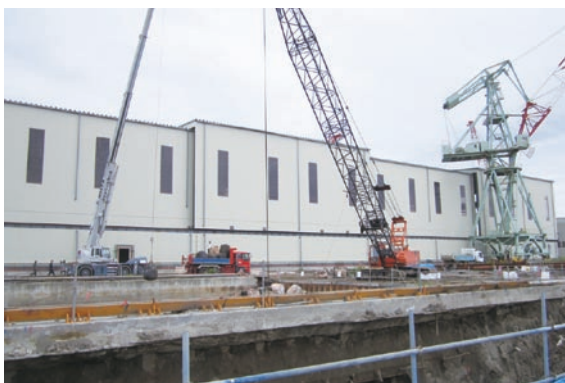
被災工場(造船業)の修復工事の様子
