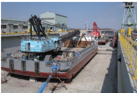
使用が開始された修復ドック
