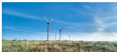
テキサス州ブラゾース陸上風力発電所
