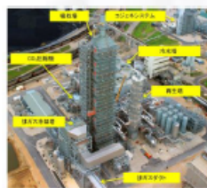
CO2分離回収技術(アミン吸収法商用例)
