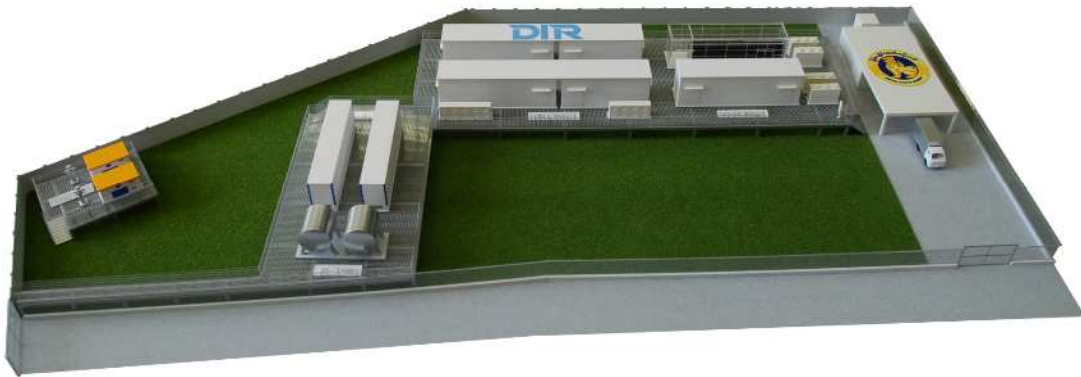
写真:ヤンゴン市内に設置予定のコンテナ型データセンターの模型
